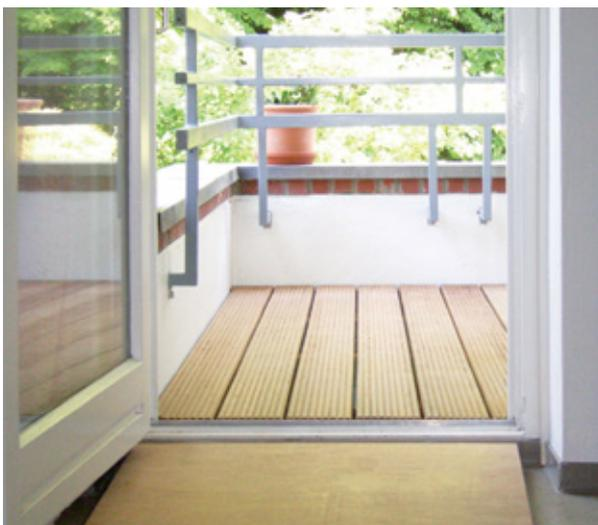
Bei einer Modernisierung lässt sich nicht immer beidseitige Schwellenfreiheit erreichen. Zumindest balkonseitig ist dies jedoch bei Aufbringung eines neuen Belages machbar. Ggf. lässt sich die bleibende Schwelle innen mit Hilfe einer kleinen Rampe ausgleichen.
