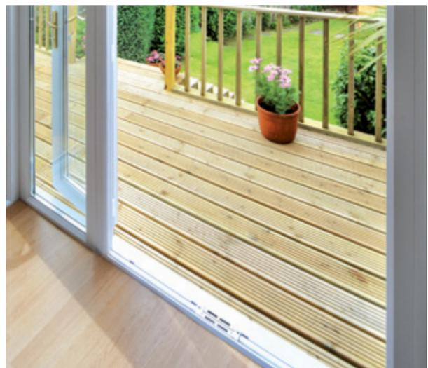
Bei einer Balkonsanierung und dem Austausch von Fenster- und Balkontüren ist ein durchgehendes, schwellenfreies Niveau innen und außen problemlos machbar.
